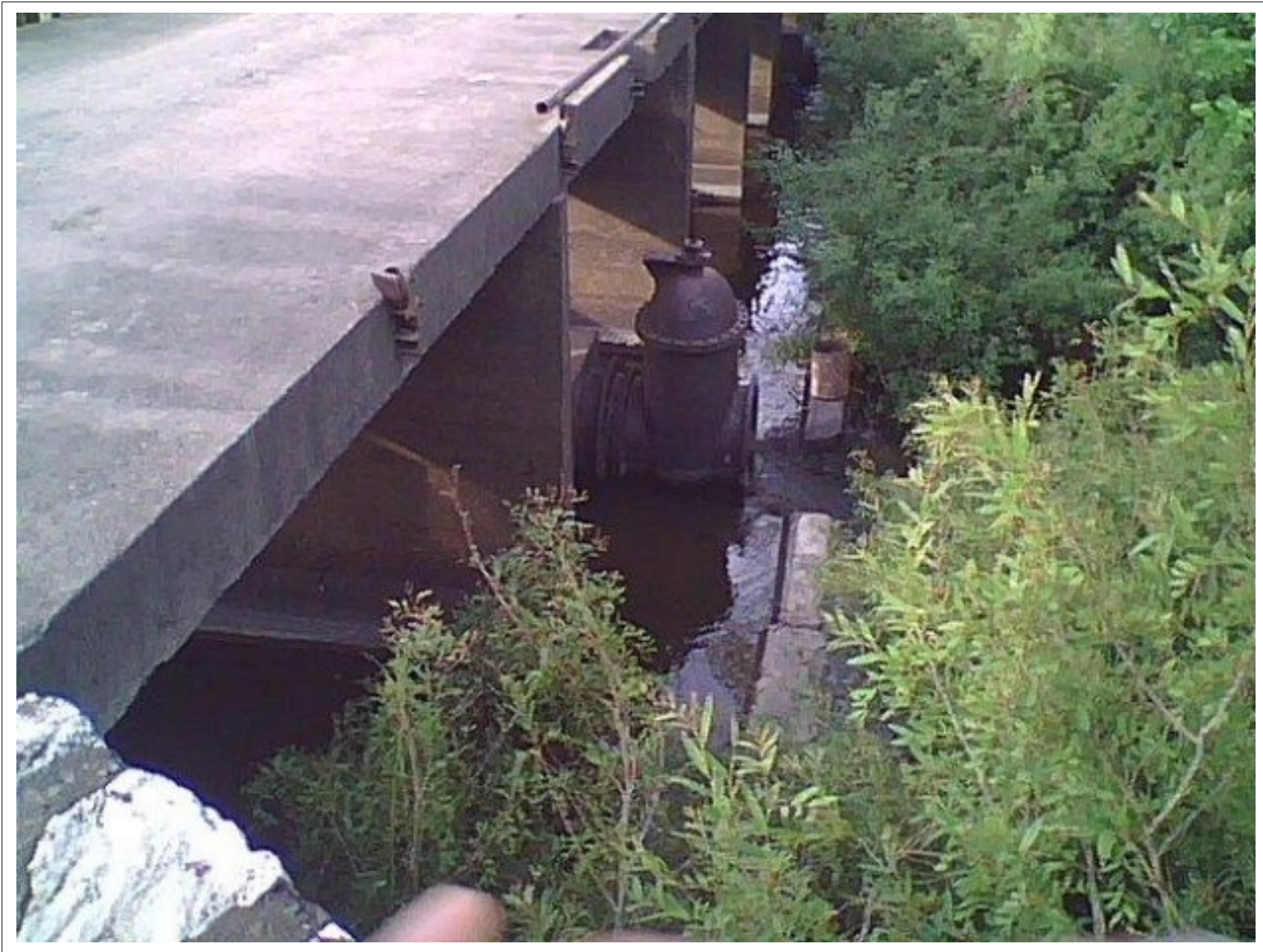
FOTO 05 - Puente de la Represa - EQUIPO LOS CHICOS FOTÓGRAFOS - Escuela N° 67, 5to. año
