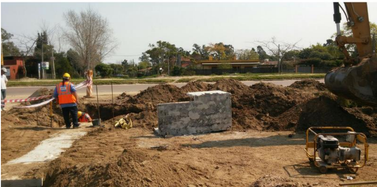
Imagen 5: Colocación de canal U: Artigas casi Giannattasio
