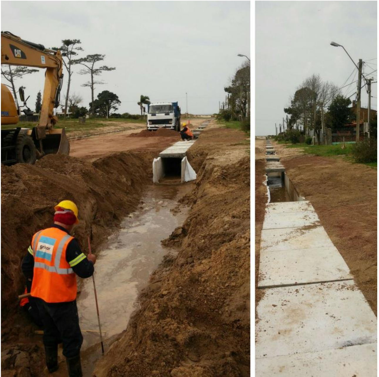
Imagen 4: Colocación de canal de hormigón U en Achiras y Rambla Costanera.
